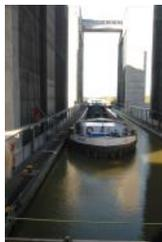
Auf der gesamten Strecke des Elbseitenkanals wird ein Höhenunterschied von 61 Metern überwunden. 23 Meter werden von der Schleuse Uelzen und 38 Meter in Scharnebeck überbrückt. Wie funktioniert das Ganze? Es werden mit zwei Riesen-Wassertrögen Fracht- und Sportschiffe über die Stufe Elbmarsch und Geest gehoben um die 38 Meter zu überwinden. Ein Trog wiegt 5.800 Tonnen, zur Bewegung dienen 224 Betonscheiben. Das ist schon sehr beeindruckend.
