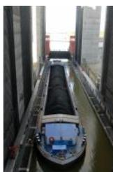
Frachtschiffe können damit eine Höhe von 38 Metern überwinden. Acht Jahrzehnte dauerte es, die Verbindung zwischen Elbe und Mittellandkanal zu schaffen.
